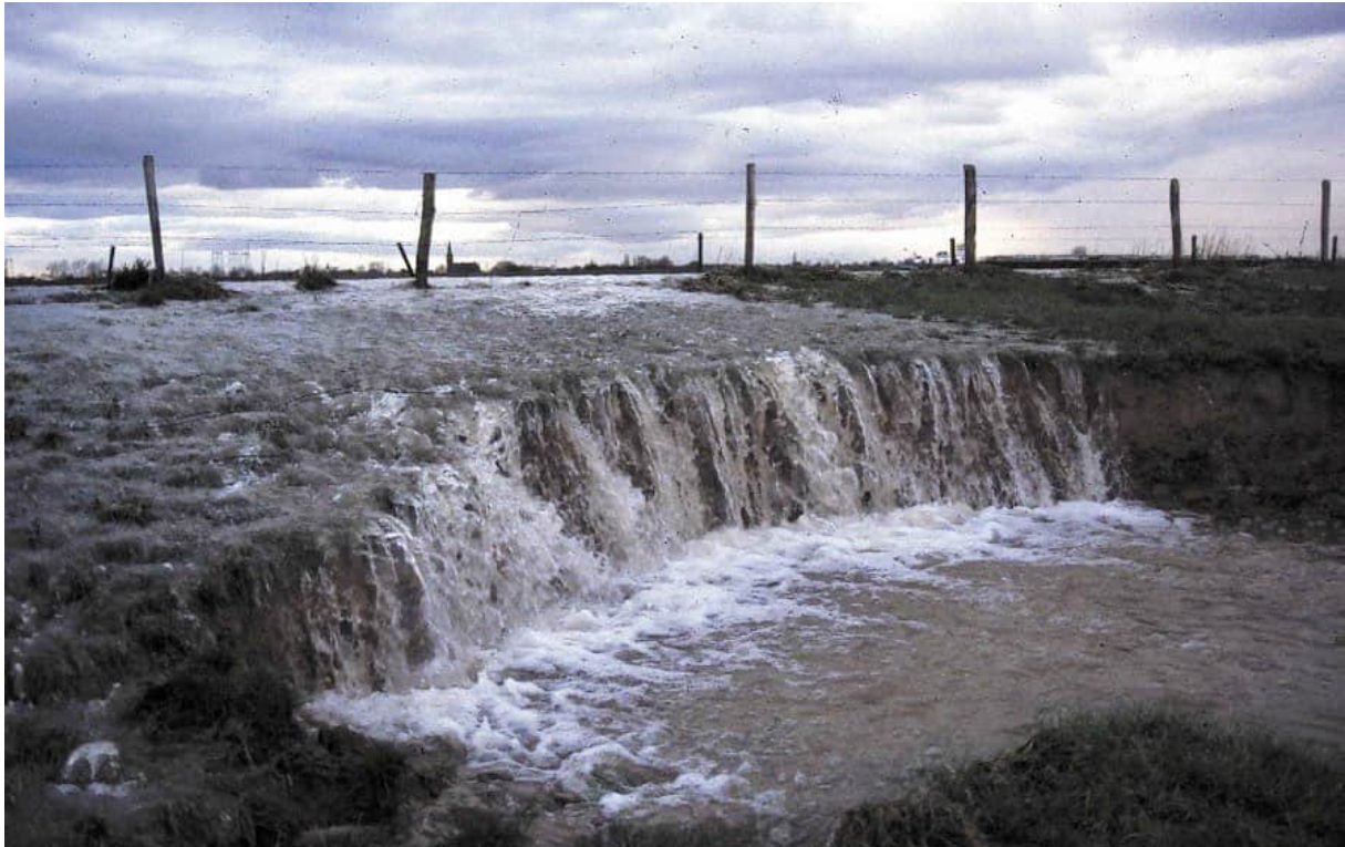
Afbeelding 3.1d: Instroom van water over de zomerkade bij opkomend hoogwater; in dit geval met erosie tot gevolg, omdat de waterstand buitengaats veel sneller steeg dan binnengaats.
